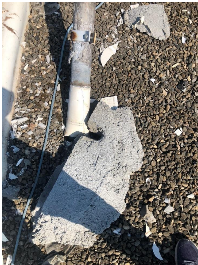
Figura 2: Danneggiamento dell'insegna e del manto impermeabile MAPEPLAN T B a causa di un fortuale
