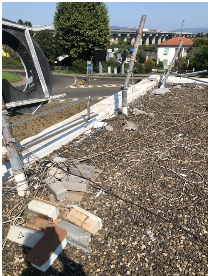
Figura 2: Danneggiamento dell'insegna e del manto impermeabile MAPEPLAN T B a causa di un fortuale
