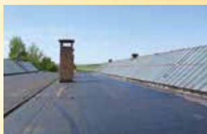
Reformas en membranas bituminosas
