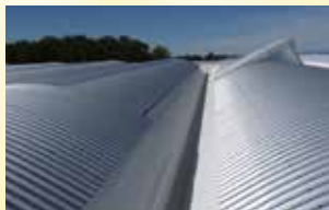
Revêtements en tôle
