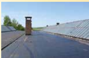
Rénovation sur revêtements bitumineux
