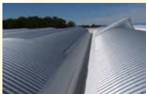
Lamiere di copertura
