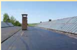
Rifacimenti su manti bituminosi
