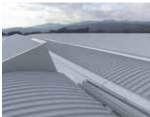
Coberturas de chapa
