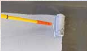
Aplicación sobre vieja membrana bituminosa
