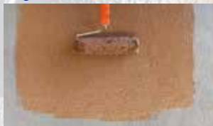
Aplicación sobre cemento
