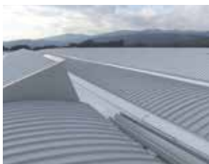
Toitures en tôles
