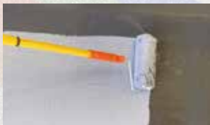
Application sur une vieille membrane bitumineuse
