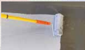
Applicazione su vecchia membrana bituminosa
