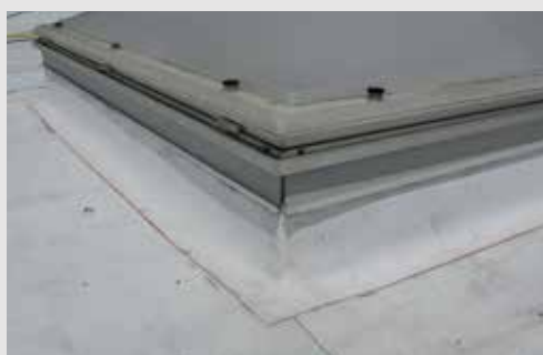
Impermeabilizzazione lucernai
