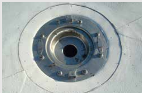
Impermeabilizzazione lucernai
