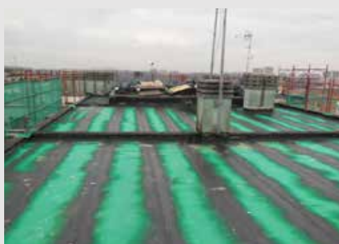
1° fase: rimozione degli strati precedenti e posa dell'impermeabilizzazione provvisoria con funzione di barriera al vapore
