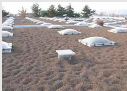
Stato di fatto della copertura prima dell'intervento
