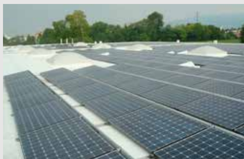
Rifacimento completato con manto MAPEPLAN® TM 18 B ROOF (t2)
