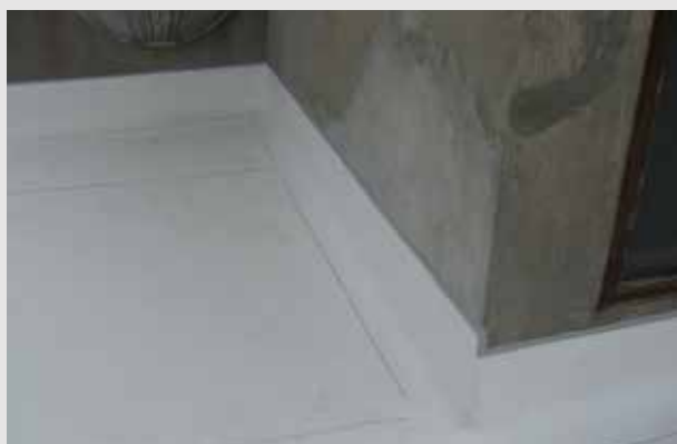
Raccordo del manto al volume tecnico
