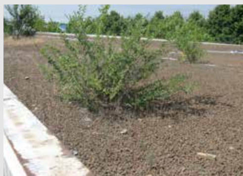
Vegetazione in copertura
