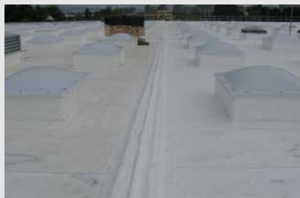
Dettaglio del giunto di dilatazione
