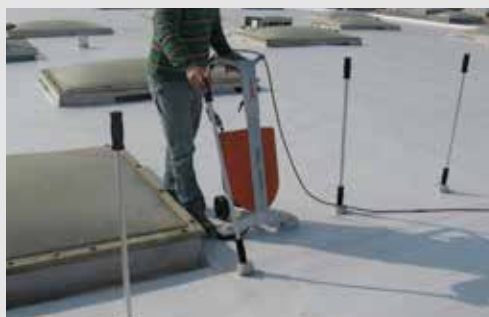
Fissaggio meccanico a induzione
