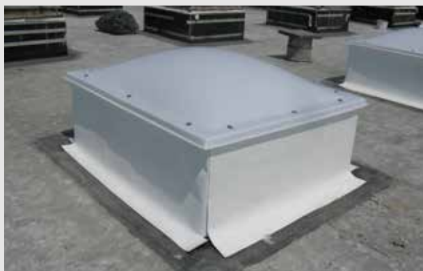
Impermeabilizzazione dei lucernari con basamenti rialzati
