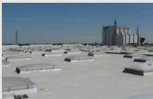
Rifacimento completato con manto Cool Roof
