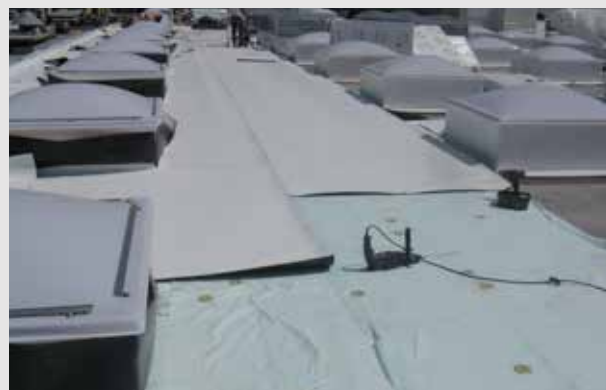
Posa dell'isolante e del manto impermeabile con fissaggio meccanico ad induzione
