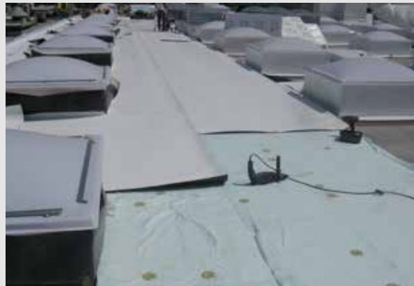
Posa dell'isolante e del manto impermeabile con fissaggio meccanico ad induzione
