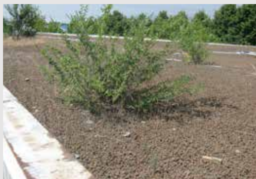
Vegetazione in copertura
