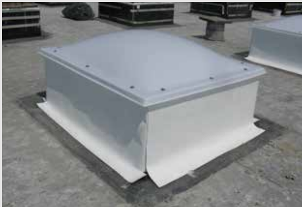
Impermeabilizzazione dei lucernari con basamenti rialzati
