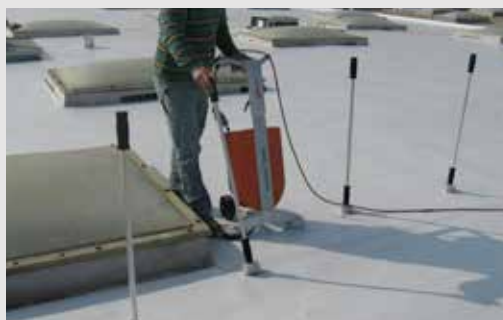
Fissaggio meccanico a induzione
