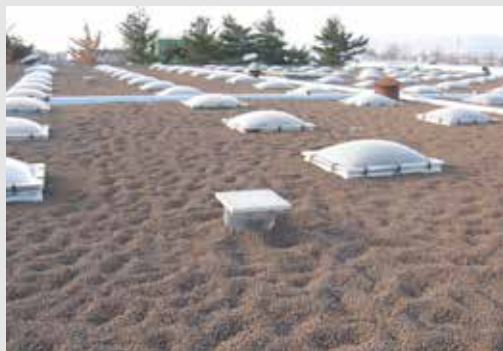
Stato di fatto della copertura prima dell'intervento
