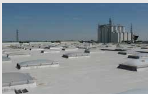
Rifacimento completato con manto Cool Roof
