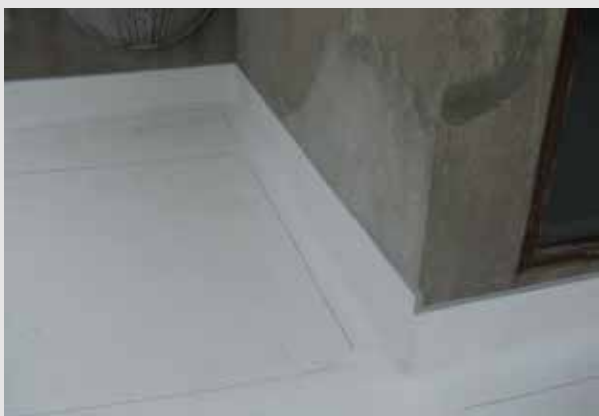
Raccordo del manto al volume tecnico
