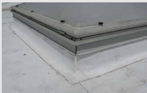
Impermeabilizzazione lucernai
