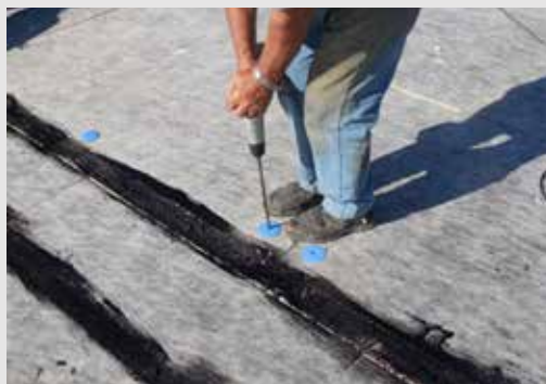
Posa dei pannelli isolanti sfalsati e fissati meccanicamente
