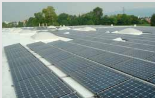
Rifacimento completato con manto MAPEPLAN TM 18 B_{ROOF}(t2)
