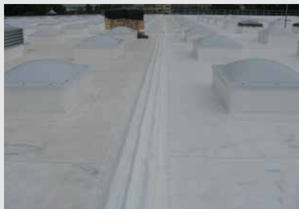
Dettaglio del giunto di dilatazione
