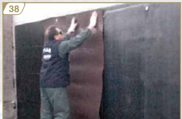
15. L'applicazione avviene anche in questo caso, con il fissaggio meccanico nella parte superiore *(immagine 39)*, con le bugne rivolte verso la membrana bitume polimero. Le sovrapposizioni sono da effettuare come riportato nella documentazione tecnica.
