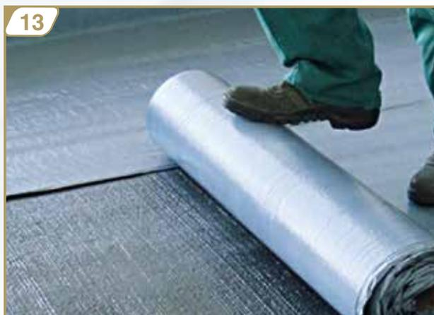
3. La saldatura avviene per contatto diretto delle sovrapposizioni.
