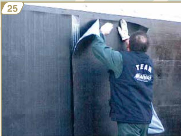
7. Con particolare cura, deve essere effettuato il raccordo orizzontale in corrispondenza del Bordangolo. Si possono eliminare eventuali tracce d'aria con il semplice passaggio della mano sulla superficie esterna del manto impermeabile. *(immagine 27)*
