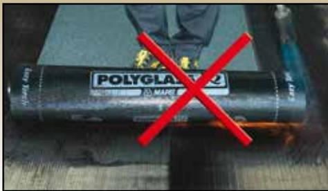
Le membrane autoadesive con tecnologia **ADESO**® vengono applicate senza uso di fiamma. I dettagli o le zone non adesive possono comunque essere trattate con Leister ad aria calda, mastice bituminoso o sfiammatura tradizionale leggera.
