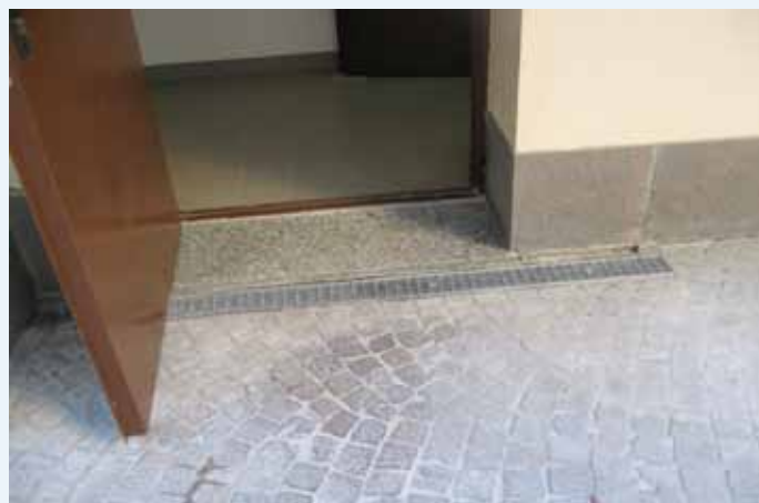
Soglia completata, con contenimento esterno rilevato di circa 20 mm, e posizionamento frontale di una canaletta grigliata, atta a raccogliere l'acqua proveniente dalla pavimentazione, posta in leggera pendenza verso la soglia.
