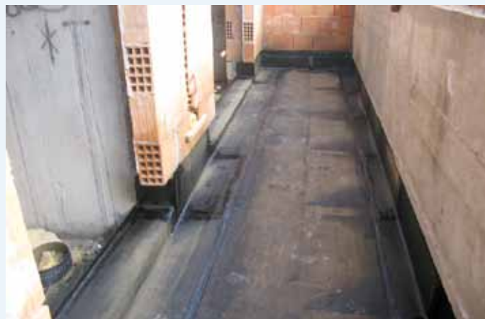
Rivestimento completato delle vaschette sottosoglia, con membrane in bitume polimero.
