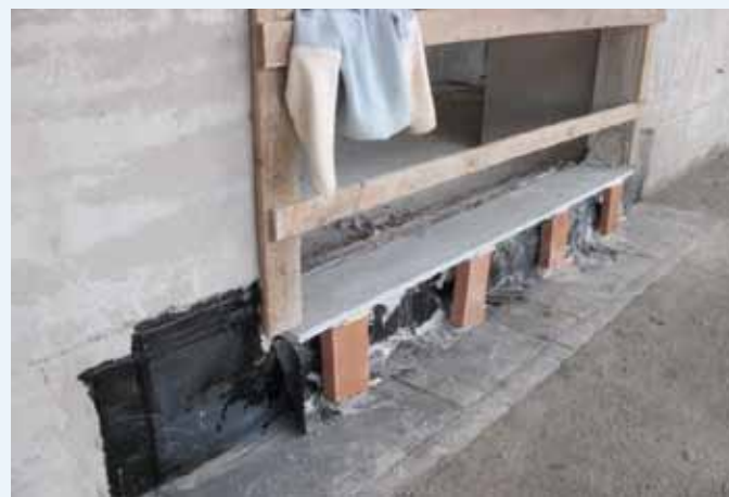
La soglia viene successivamente posizionata ed allestita nel contenimento a vaschetta. Si nota il prolungamento dell'impermeabilizzazione, in orizzontale sul massetto delle pendenze, per permettere la successiva ripresa dell'impermeabilizzazione.
